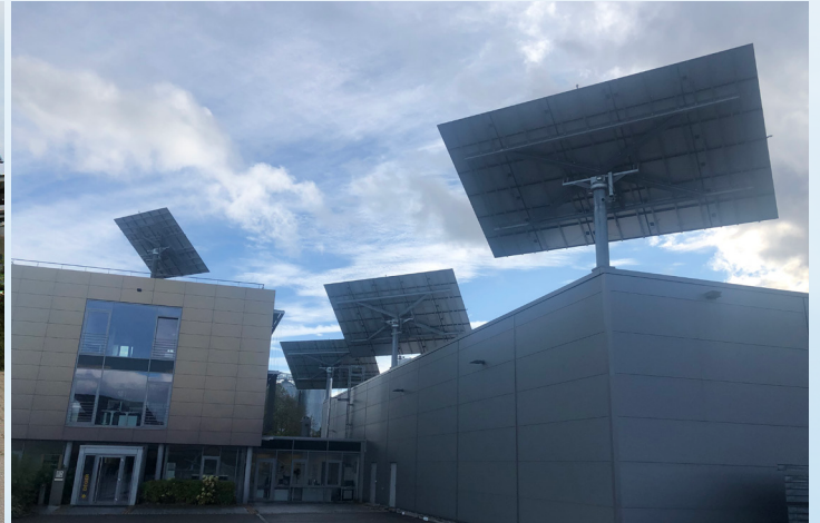
Solar Tracker auf Parkplatz / Garage Gebäude. Installation an Gebäudefassade (links) und auf Dach (rechts).
