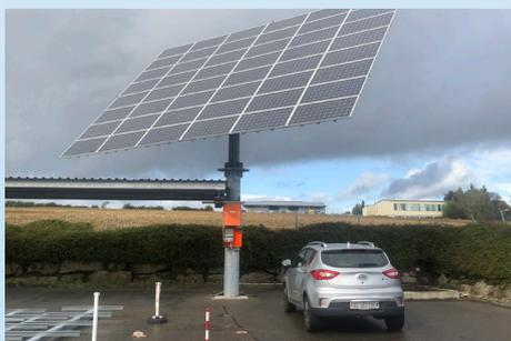
Solar Tracker mit Hochleistungspanelen im Einsatz.
