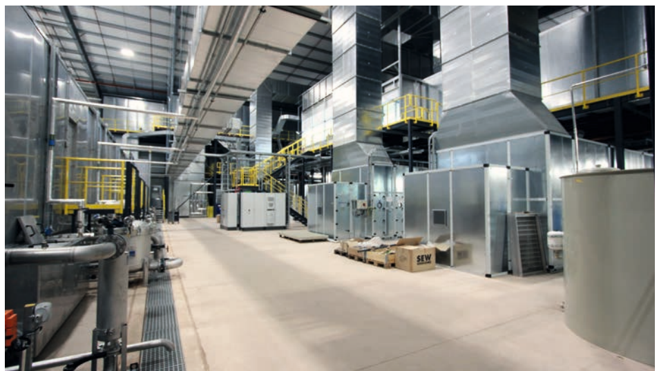
Neue Werkhalle am Standort Telford
