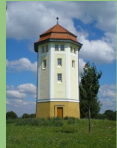
Wasserturm bei Abtsgmünd-Hohenstadt
