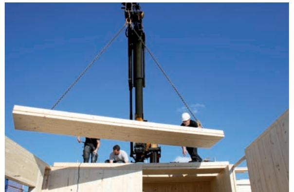
Die Brettstapel-Decken-Module wurden direkt per Lastwagenkran auf die Massivholzwände gehoben. Dort wurden sie plangemäss positioniert und eingepasst
