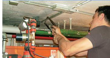
6. Die Aktivanode arbeitet ohne chemische Zusätze, Regeneriersalz oder Strom. Das gelbgrüne Kabel dient allein dazu, die Erdung der Wasserleitung nicht zu unterbrechen.
