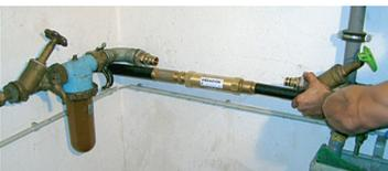
3. David Deptuch befestigt die neuen Rohrstücke aus Verbundmaterial mit einem speziellem Presswerkzeug an Muffen auf den alten Rohrenden.
