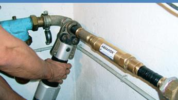
4. Die große Aktivanode arbeitet, wie David Deptuch dem Hausbesitzer erklärt, in der Kaltwasser-Zuleitung direkt hinter Absperrventil und Filter am effektivsten.
