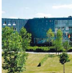
Das Firmengebäude der deutschen Niederlassung von Novo Nordisk in Mainz
