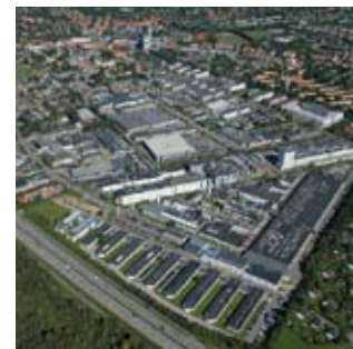
Produktionsanlage im dänischen Bagsværd
